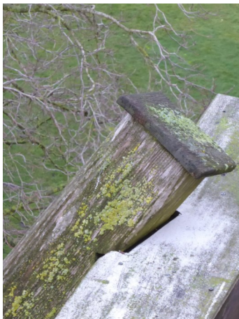
Kop van de balk wordt beschermd tegen de regen door een kopplaatje
