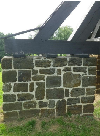
Verluchte regenplanken op de meesterbanden en op de uiteinden van de kruisplaten
