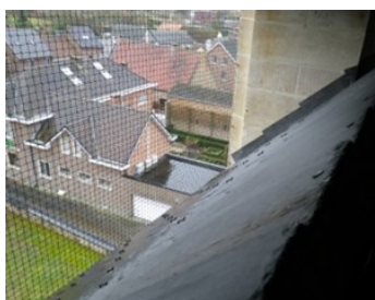
Plaats gaas aan de buitenzijde van de galmboarden zodat duiven niet op de galmboarden kunnen nestelen. ①
