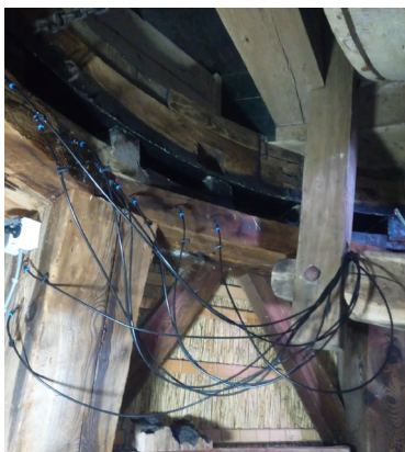
Dieptebehandeling met vloeibare insecticide (foto © Hoekstra).
