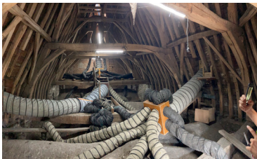
Warmtebehandeling met hete lucht (foto's © PERSPECTIV architecten).
