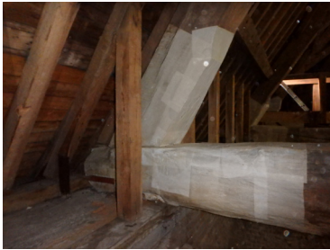
Detectiepapier op kapconstructie.
