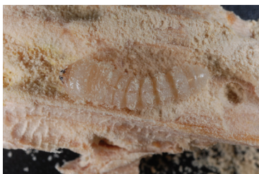
Larve richt schade toe aan het hout.
