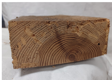
Doorsnede: merk op dat de aantasting zich beperkt tot het spinhout en het hardere kernhout niet is aangetast.
