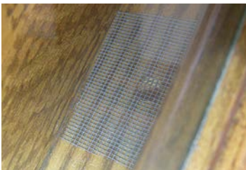
① Gaas voor verluchtingsgat
