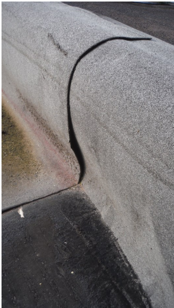
Slecht gevloeiende naden van de dakbanen met lekken tot gevolg.
