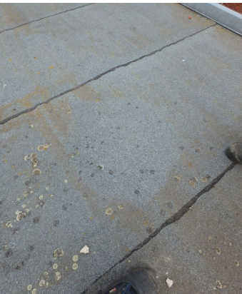
Goed gevloede naden tussen de verschillende dakbanen.
