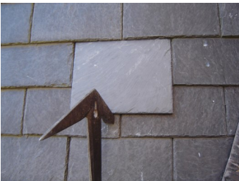
Lei vervangen stap 3: de nieuwe lei wordt op zijn plaats geschoven.
