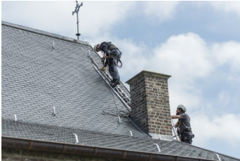
Monumentenwacht aan het werk op een dak in natuurleien.
