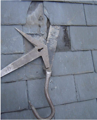
Lei vervangen stap 1: kapotte leien en bevestigingsnagels of -haken worden met een rooi-ijzer verwijderd.
