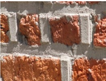
Beschadigde baksteenheid door agressieve reiniging
