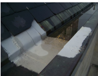
Duurzame herstelling met vloeibare EPDM.
