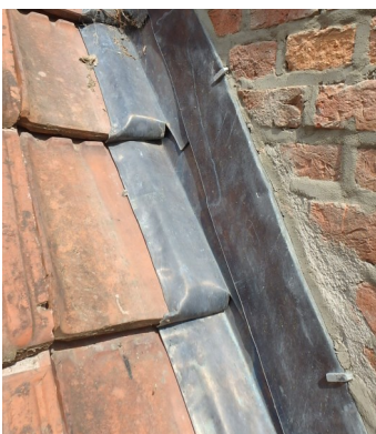
Vakkundige herstelling van de loden aansluiting tussen pannen en opgaand muurwerk.
