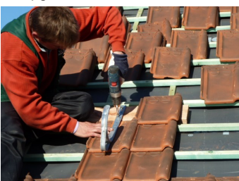
Aanbrengen van een ladderhaak.
