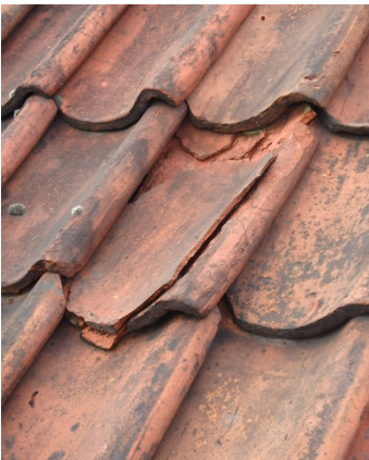
Afschilferende dakpan.
