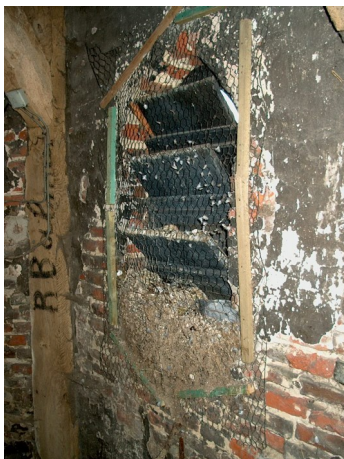
don't: afschermen galmgaten met hexagonaal gaas
